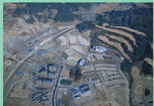
電源地域の産業団地
