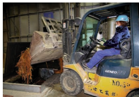
発電用の大型ボイラーに原料の木くずを投入する
