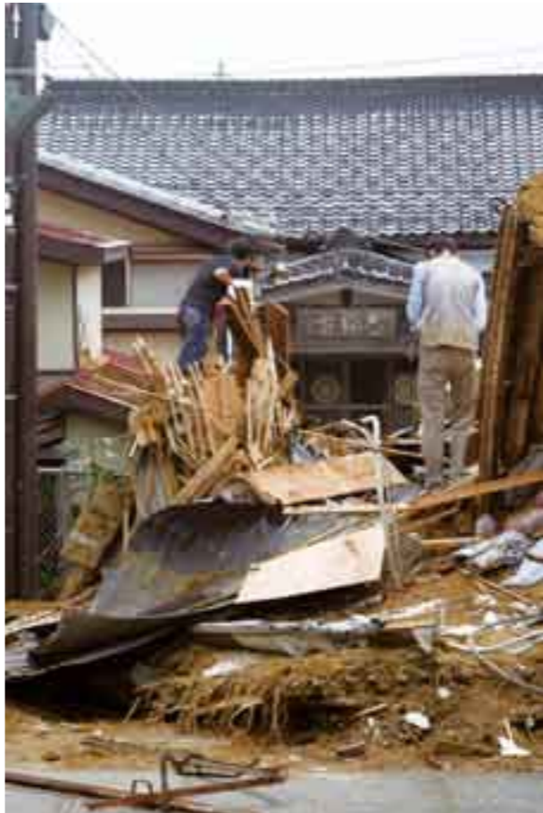
倒壊した家屋。突然の震災で全壊した家屋も多かった
