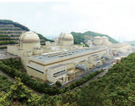
大飯発電所：面積約188万m 2 の広大な敷地にあり関西電力では最大の発電所として4基合わせた総出力が471万kW。(写真は関西電力㈱提供)。
