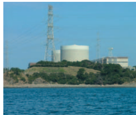
町の北部に位置する九州電力(株)玄海原子力発電所は総出力347.8万kWの九州初の原子力発電所。
