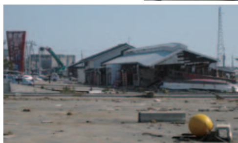
流された船が激突して大破した建物
