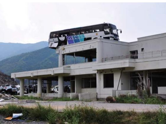
津波によって雄勝町の町並みは全て破壊された
