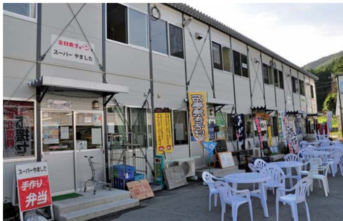
石巻市の旧雄勝支所前に設けられた仮設商店街
