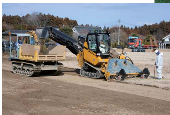
急ピッチで進められている除染作業
