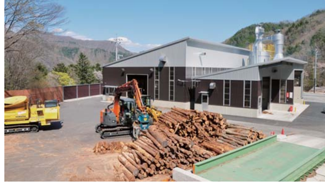
木質ペレット製造工場
