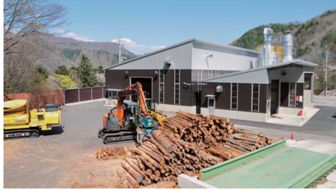
木質ペレット製造工場
