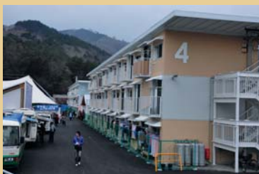
3階建ての仮設住宅
