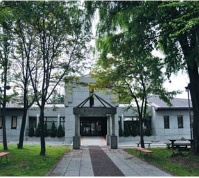
写真文化ギャラリーのある建物。東川賞受賞者をはじめ、内外の写真家のオリジナルプリントを収蔵している
