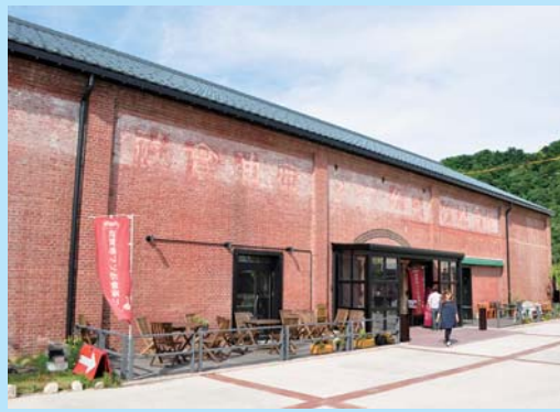
敦賀赤レンガ倉庫
