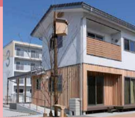
復興公営住宅勿来酒井団地。手前が戸建て、奥が集合住宅
