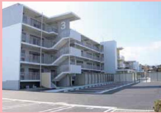
復興公営住宅勿来酒井団地の集合住宅
