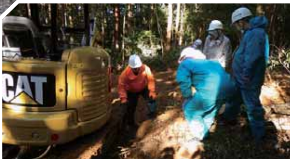
「自伐型林業研修」の作業道敷設研修(佐川町)
