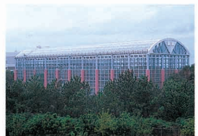
九州電力が建設中の大規模温室 面積1,300㎡、天井高18mの大規模温室。 熱帯植物園、ヨーロッパ庭園、棚田庭園などを備え今春オープン予定です。
