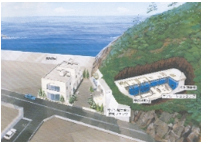
トンネル方式の処理場イラスト図
