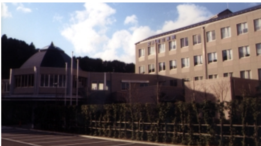
病床数100床を備え、救急病院にも指定されている女川町立病院。
