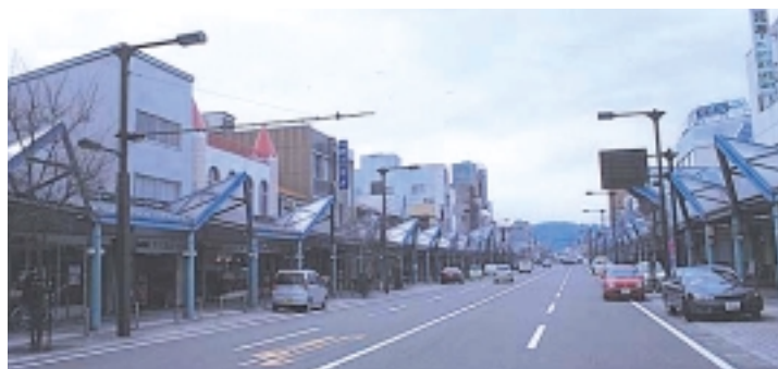
ハード整備が終了した中心部市街地
