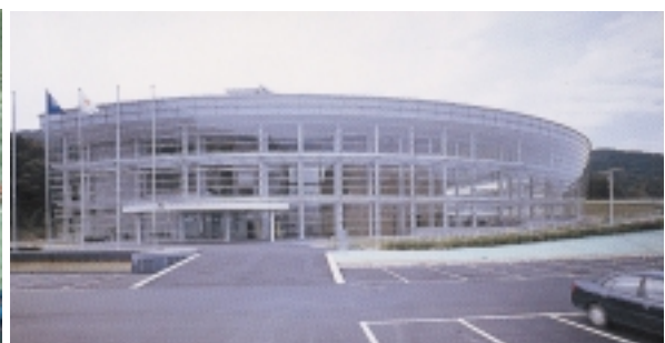
若狭湾エネルギーセンター
