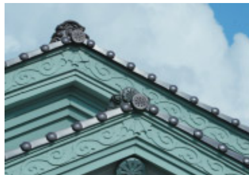
旧生野警察署 木造平屋建。妻側屋切り部分には、警察紋章と当時の町章が残っている
