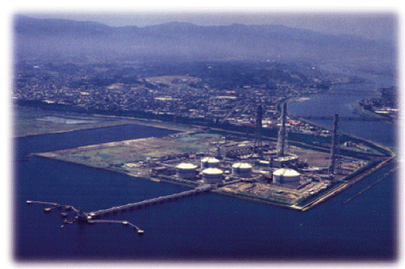
新大分発電所
