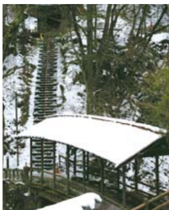
長野県 上田市丸子地域「鹿教湯温泉五台橋」
