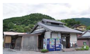
「高原霧の里休憩所」
