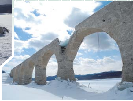
湖面に姿を現したタウシュベツ川橋梁
