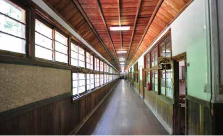
国の登録有形文化財に指定されている旧山形小学校の木造校舎。山形地区振興協議会が空き教室を企業への貸し出しや林業展示などに活用している
