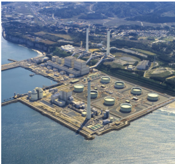
広野火力発電所
