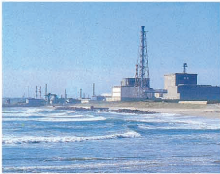
日本原子力発電(株)東海第二発電所
