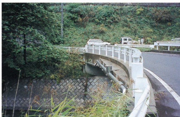
橋りょうに添って配水管を敷設した箇所
