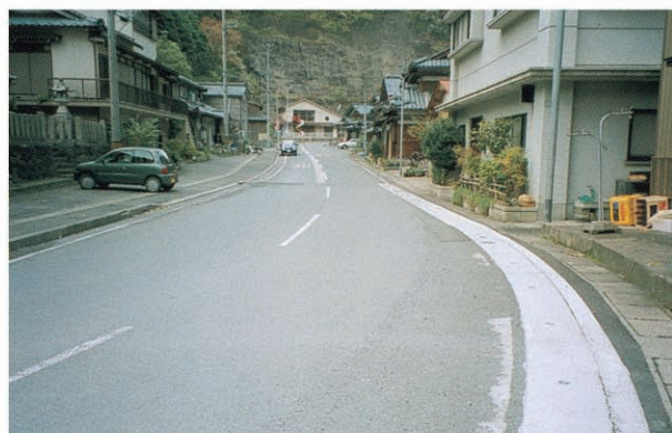
道路に散水管を敷設した
