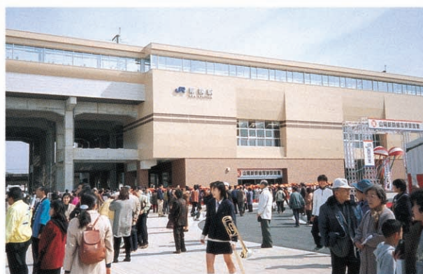
開業した山陽新幹線厚狭駅
